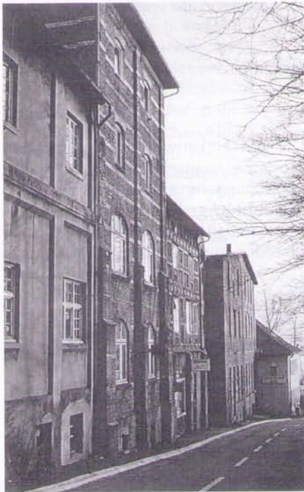
Die unmittelbar am Ostrand der Baron-Voght-Str. stehenden bis zu fünfgeschossigen ehem. Brauereibauten. (Aufn. 1967)
