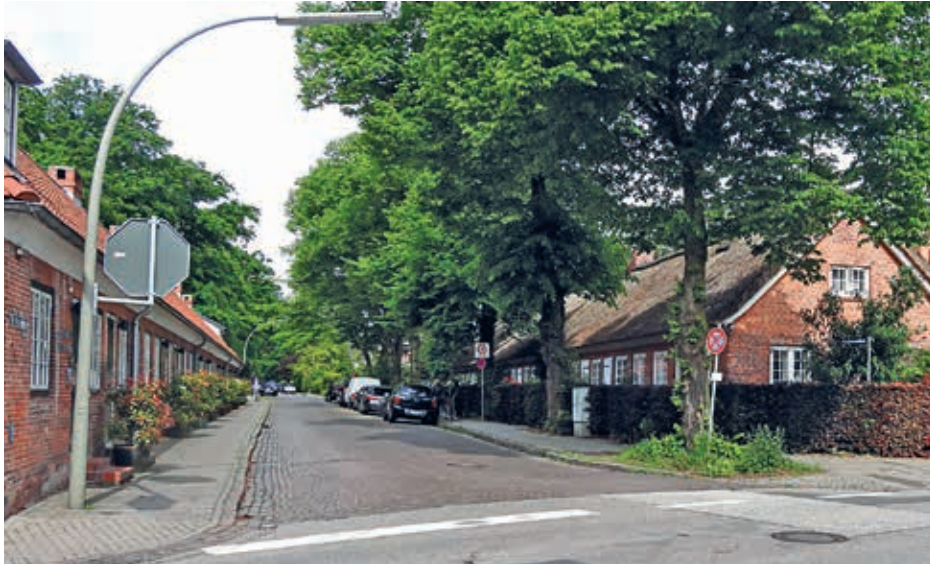
Instenhäuser in der Jürgensallee
