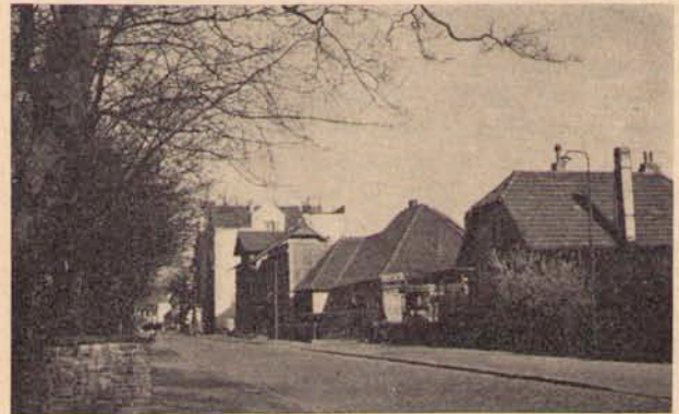
1961: Georg-Bonne-Straße 64-76 Aufnahme von H. Cords
