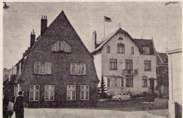
Südseite der Hasselmannstraße 1961 links: die umgebaute ehem. Nienstedtener Schule rechts: Haus Krümmel, erbaut 1907
