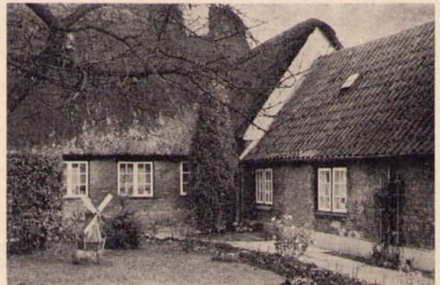
Haus Ladiges, Südseite mit Anbauten an der SO-Ecke. Aufn. H. Cords
