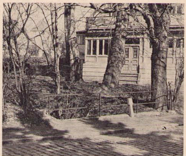
Die „Kleine Flottbek“ von der Kanzleistraße gesehen. Das Gitter schützt den Fußgänger vorm Abstürzen in den Bach (gegenüber der Baumschule v. Ehren).
