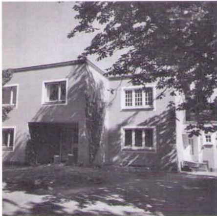
Bild 1: Schulkamp 22 vor dem Abriß. Von dem alten, mehrfach um- und angebauten Haus von 1890 war nichts mehr zu erkennen.
