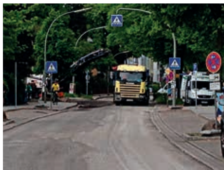
Das Abfräsen der Straße
