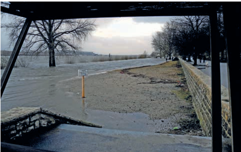
Heute schützen verschiedene Baumaßnahmen „Strand“ und Hang wie hier zwischen Teufelsbrück und Nienstedten Höhe Hotel Jacob.
