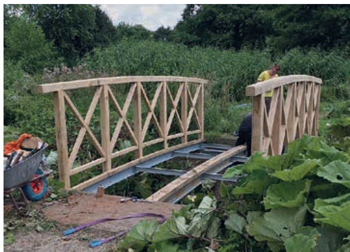
Bauarbeiten an einer der neuen Brücken
