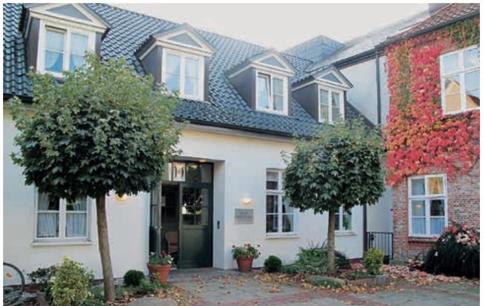
Bild 8. Wo einst der Saaleingang war, ist seit 1988 der Eingang zum Alten- und Pflegeheim „Haus Sieberling“, anstelle des alten, großen Saales ein kleinerer, milieugerechter Anbau.
