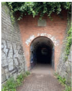
So sah der Eingang vor der Renovierung aus (Foto: R. Harten)
