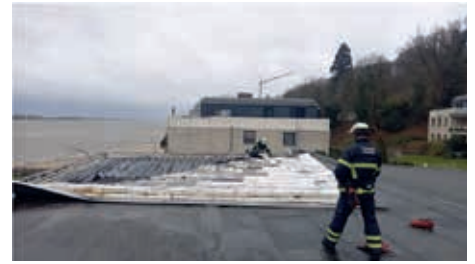
Eine Dachhaut, die sich verselbstständigt hat
