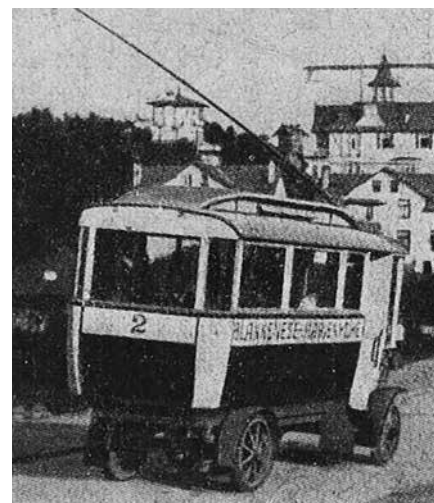
Oberleitungs-Bus in Blankenese
